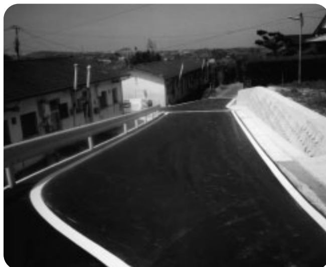
【町道高尾団地線】 一般会計 土木費
