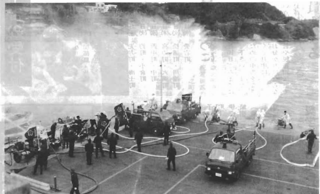
体育館前物揚場 一斉放水(出初式)
