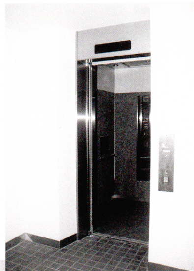
エレベーター
