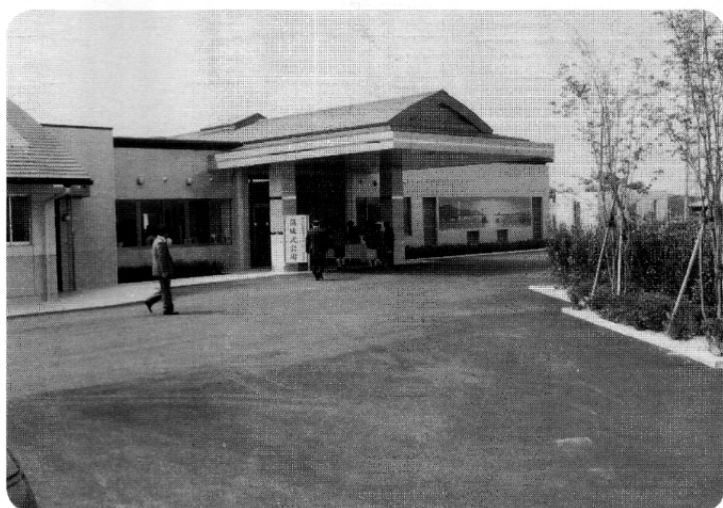
正面玄関 右手に呼子大橋と朝日の絵
