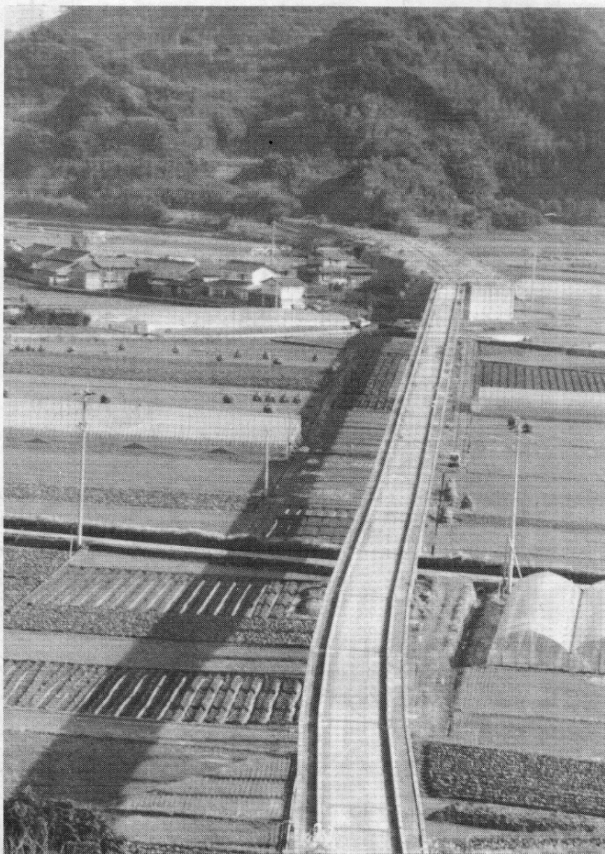
呼子線湊トンネル上より相賀を望む
