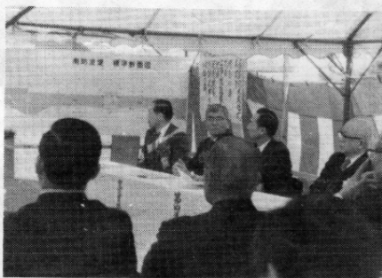
防波堤完工（51・10）
