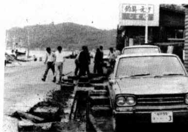
清浄中の排水溝
