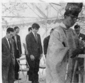
▲呼小室内体育館地鎮祭
